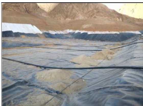
图 2-27 防渗膜铺设完成
