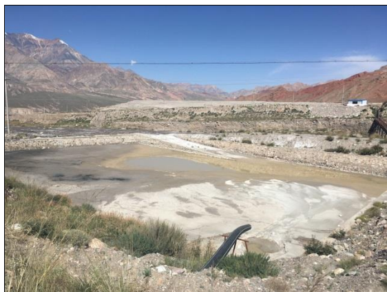
图 2-1 小柳沟河南岸现有事故池
