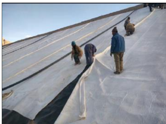
图 2-28 铺设防渗土工膜
