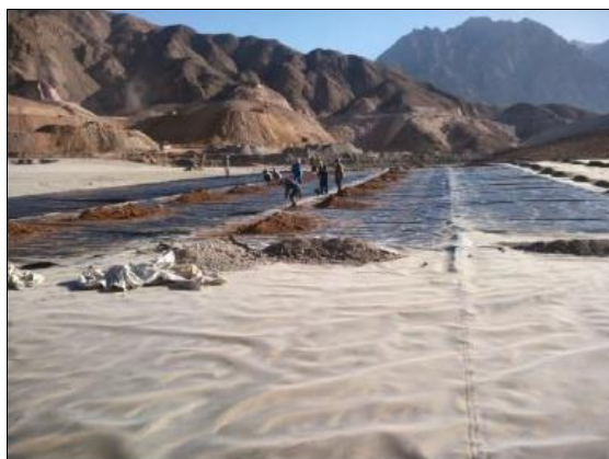
图 2-24 铺设防渗土工膜
