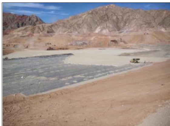
图 2-23 铺设防渗土工膜
