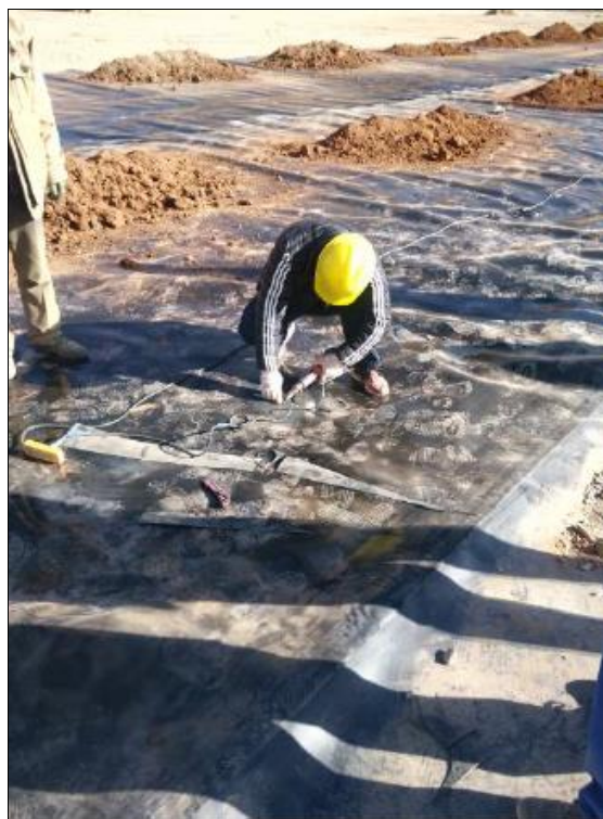
图 2-26 对破损部位进行修补
