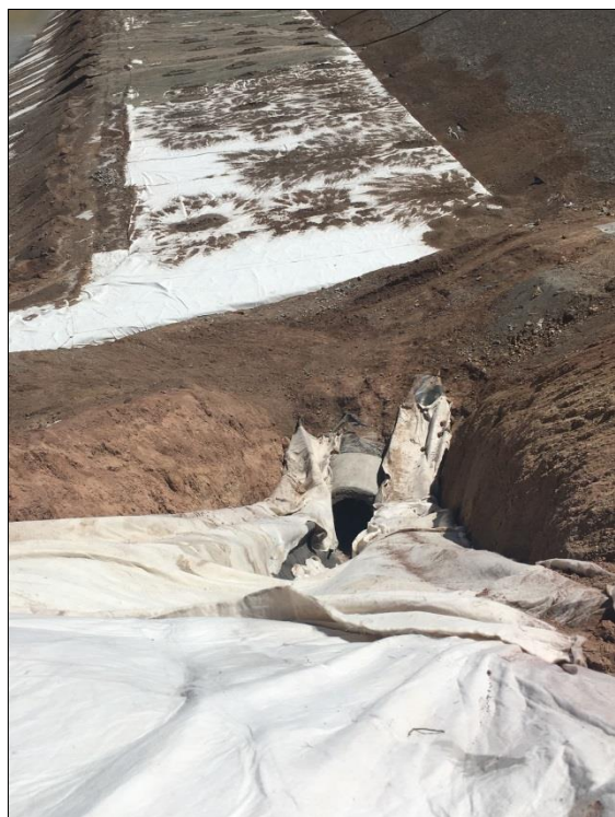
图 2-17 排水斜槽
