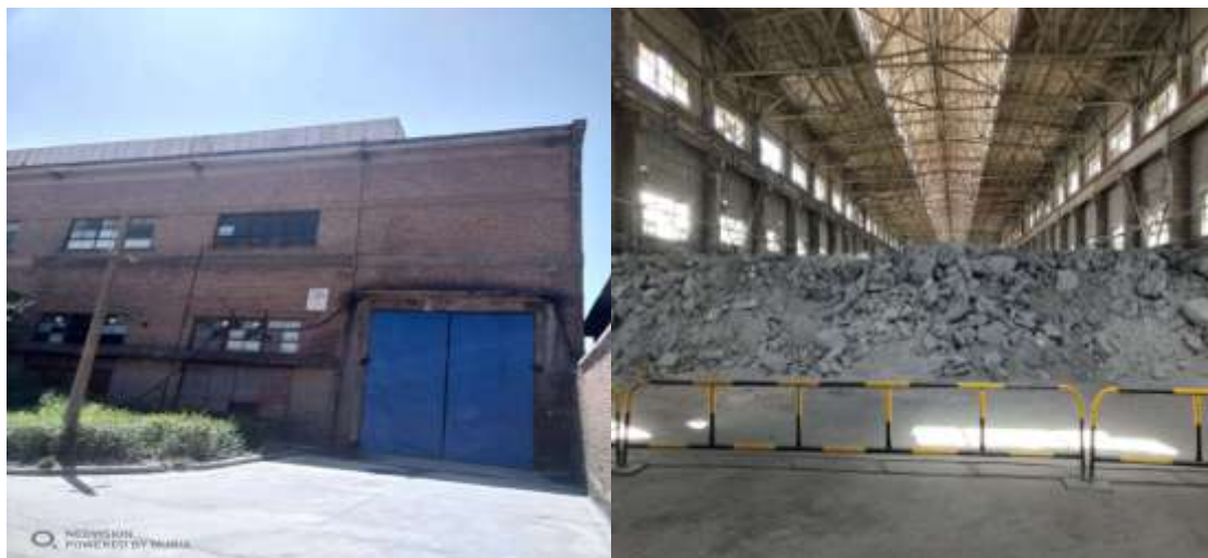
电解槽大修渣暂存设施
