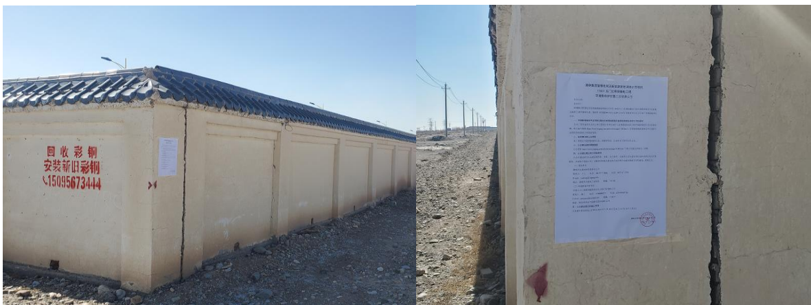
甘肃宏汇（宏汇能源 1000 万吨煤炭分质利用项目）
